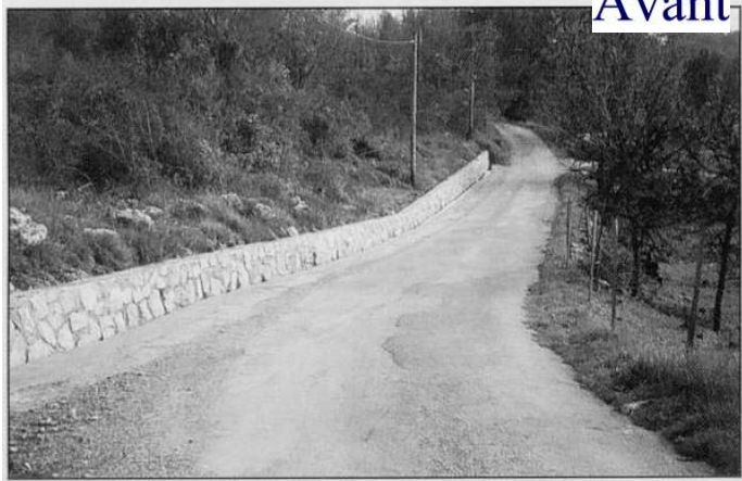
Réalisation d'un muret chemin du Magnanon.
